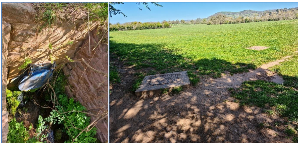
Ffigur 4-8. Gollyngfa las, gollyngfa dŵr wyneb Dŵr Cymru a cloriau tyllau gwaith yng nghornel dde-ddwyrainol Caeau Vauxhall, gollyngfa i Gwrs Dŵr Watery Lane, ymweliad safle Mai 2021
