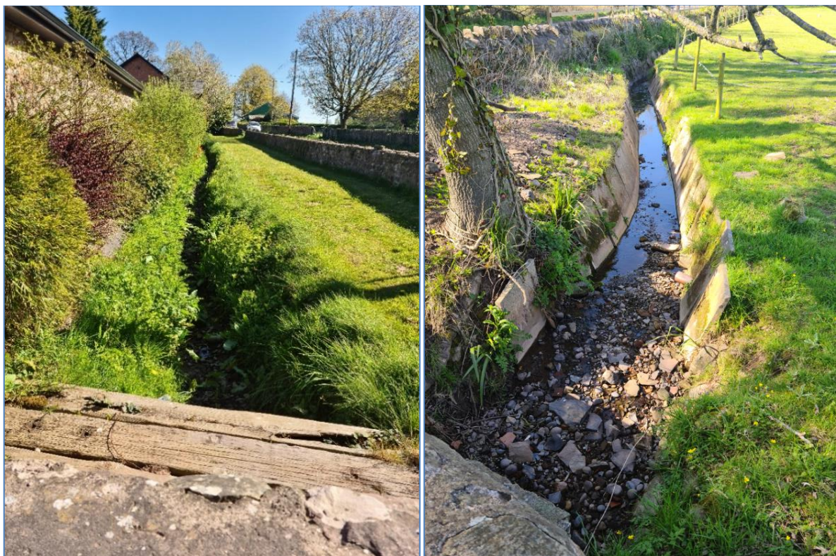
Ffigur 4-2. Cwrs dŵr cyffredin ger Pont Pant-Y-Goitre i'r de o'r Wysg, cylfat o dan Y Bythynnod, i'r chwith y fewnfa, i'r dde'r allfa, ymweliad safle Ebrill 2021
