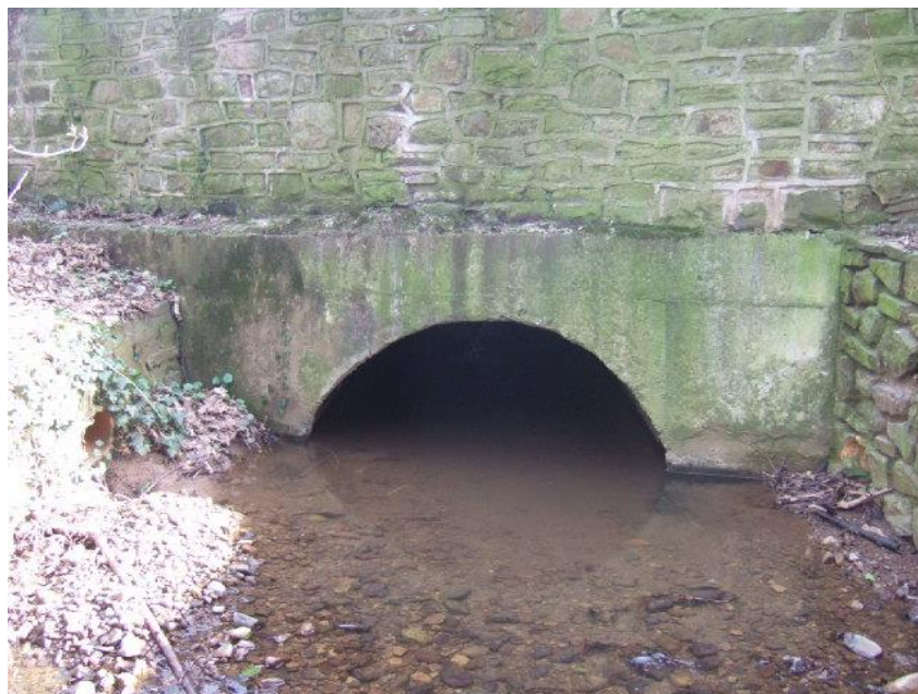
Cayo Brook Culvert, Usk Road, Llancayo
